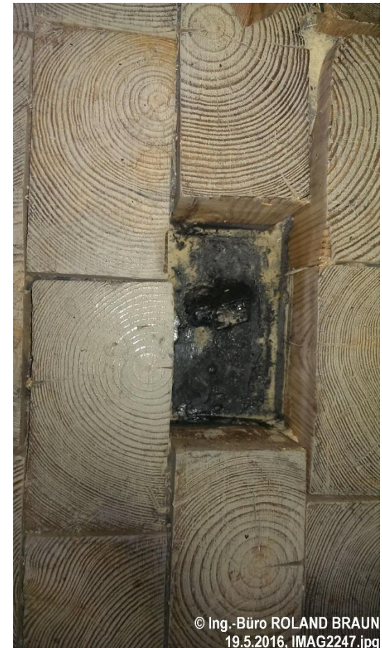
PAK-haltiger Bodenbelagskleber
