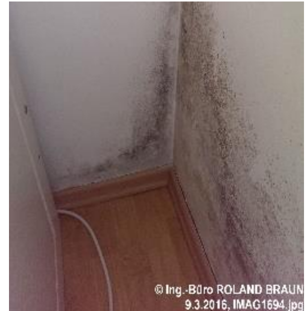
Sichtbarer Schimmelpilzbefall
