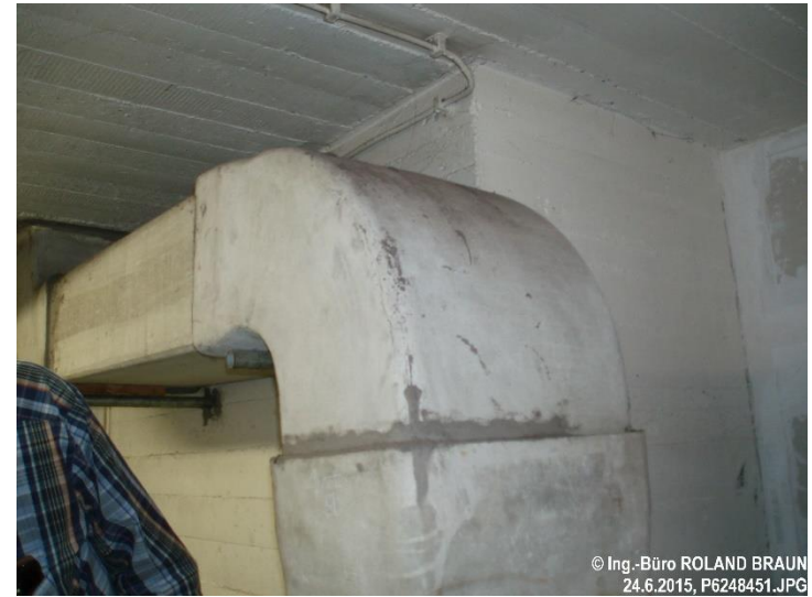
Asbesthaltiger Lüftungskanal
