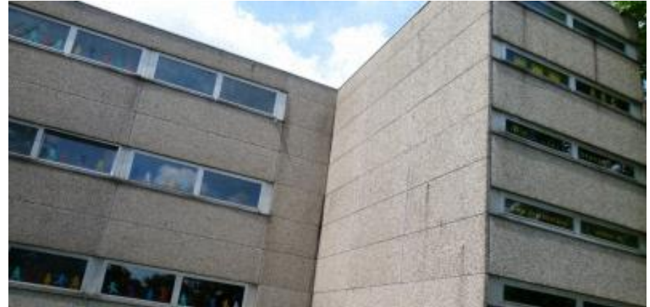
Typisches Gebäude mit PCB-haltigen Fugen
