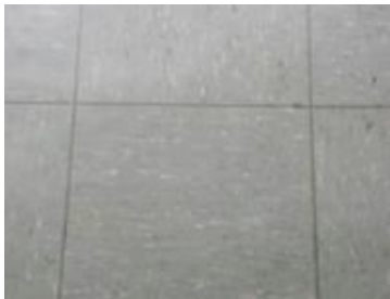
Asbesthaltige Floorflexplatte
